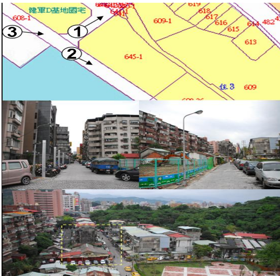
照片 3-2：臺北市中正區福和段 2 小段 645-1 地號土地現況照片
