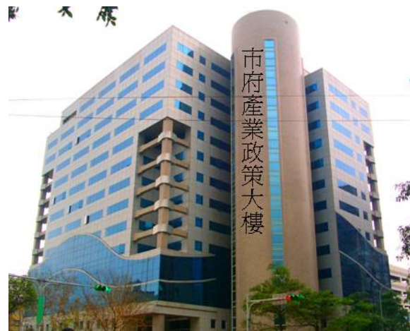
照片 1-7 公有土地多元利用立面照片
